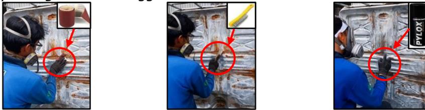
**Gambar 4. Proses repair menggunakan tools manual (amplas kain, sikat kawat dan pylox)**
